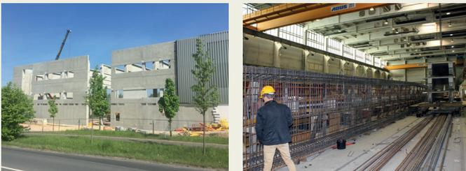
Das Projekt wurde komplett mit der BIM-Methode geplant. Neben allen Daten, die für die Produktion der Fertigteile notwendig waren, wurde das von uns erstellte BIM-Modell auch für die Verfolgung des Status für Planung, Produktion und Bauablauf genutzt.
