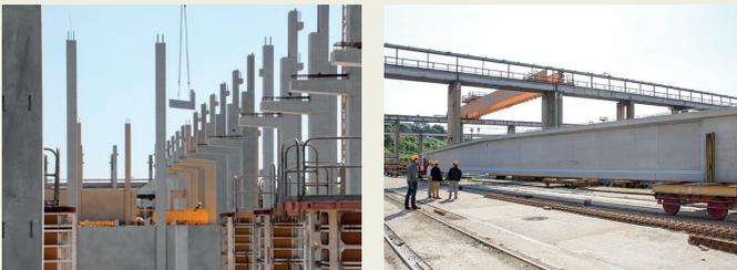
Unser Büro erbrachte bei diesem Bauvorhaben die Tragwerksplanung (statische Berechnung, Erstellung aller Schal- und Bewehrungspläne, Fertigteilplanung). Eine besondere statische und bauphysikalische Herausforderung waren die Spannbetonbinder, die mit einer Stützweite von 40 Metern die Websäle überspannen.
